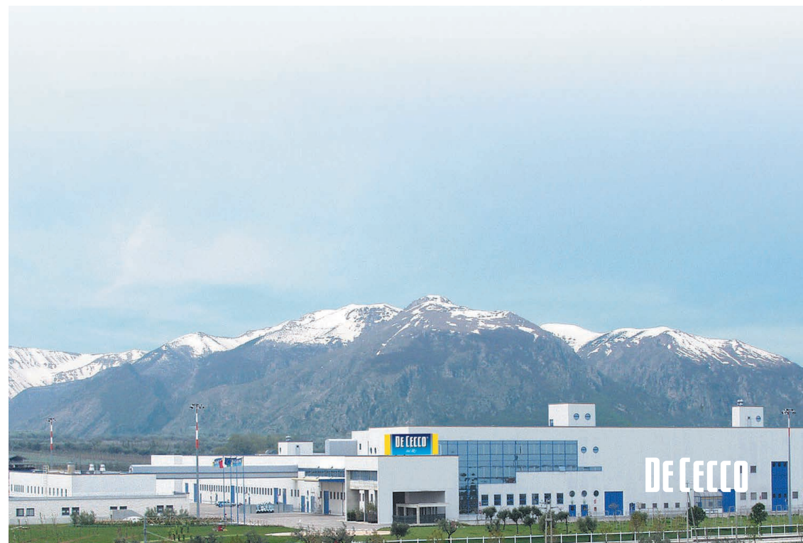
Lo stabilimento di Ortona con lo sfondo della Majella. ^
